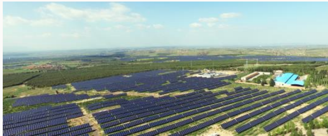
一期領跑者山西大同5MW集散式太陽能電站
