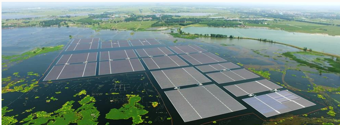
安徽潘集48MW漂浮式太陽能电站項目
