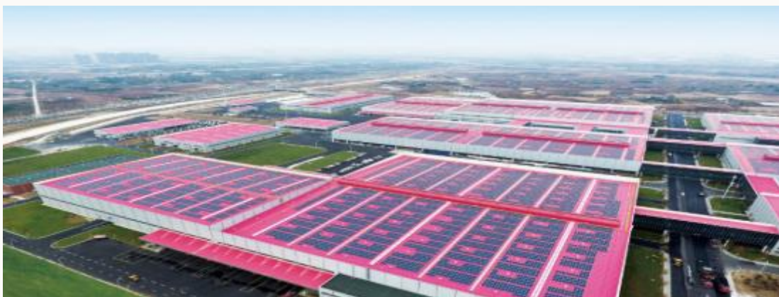
江淮汽車高端及純電動輕卡12MW分散式太陽能電站
