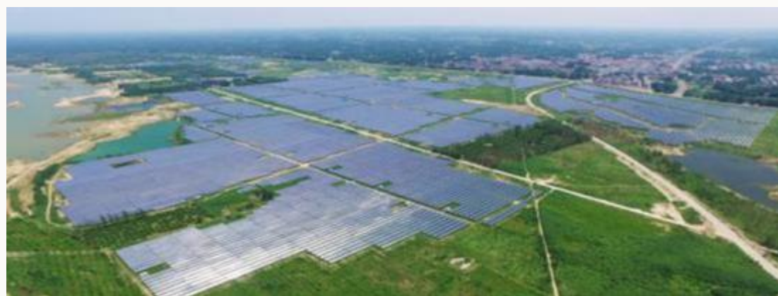
六安市裕安區蘇埠園藝場70MW太陽能扶貧電站
