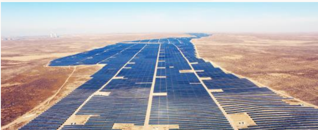
寧夏寧東300MW集中式大型地面太陽能電站
