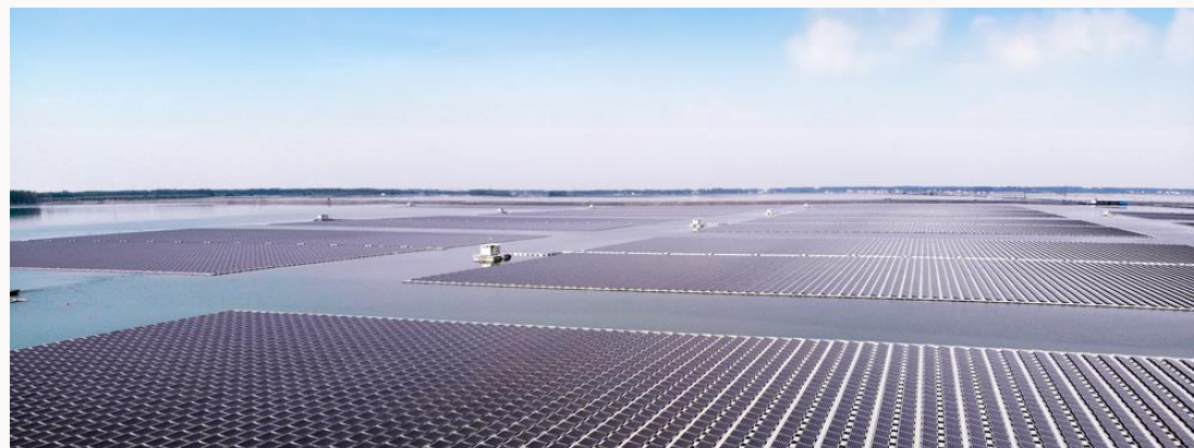
全球最大水上漂浮电站示范項目安徽顧橋150MW項目
