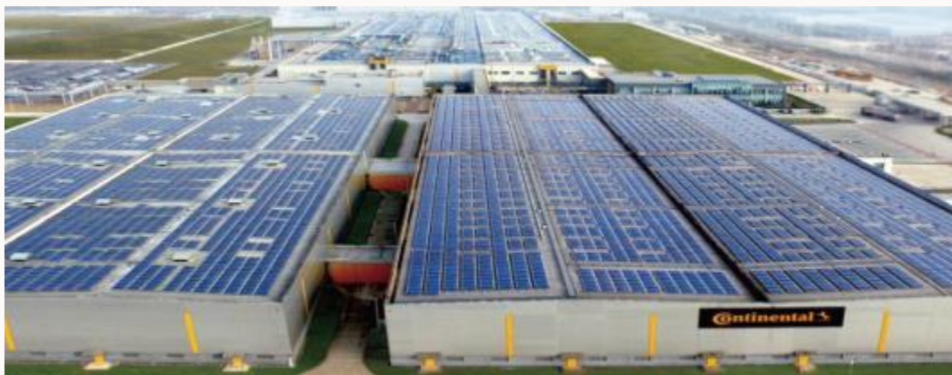
合肥國家分散式太陽能發電應用示範區100MW項目
