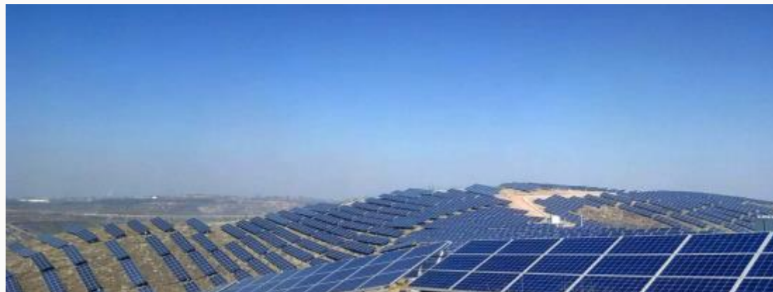
山西陽泉50MW地面集中式太陽能電站
