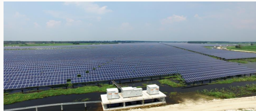
打桩式水面電站
