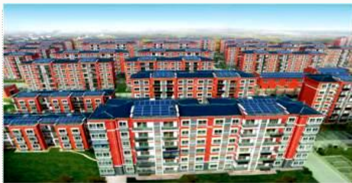
合肥市新民社區太陽能電廠
