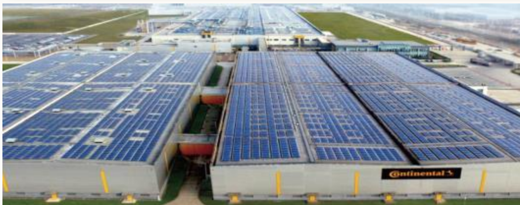
合肥100MW太陽能電廠——全國分佈式太陽能示範區
